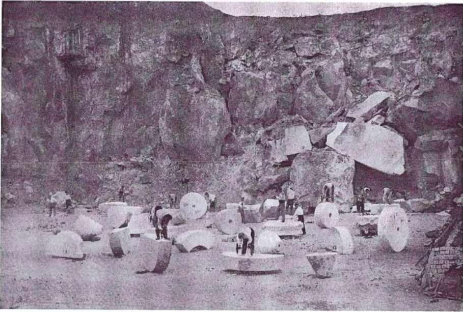
FIGURA 13. La pedrera Zafont, a Montjuïc, a començament del segle XX.
